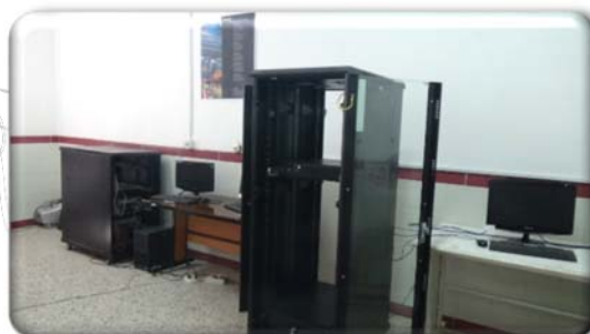
آزمایشگاه خوشه محاسباتی فضای فیزیکی: ۲۸ متر مربع
